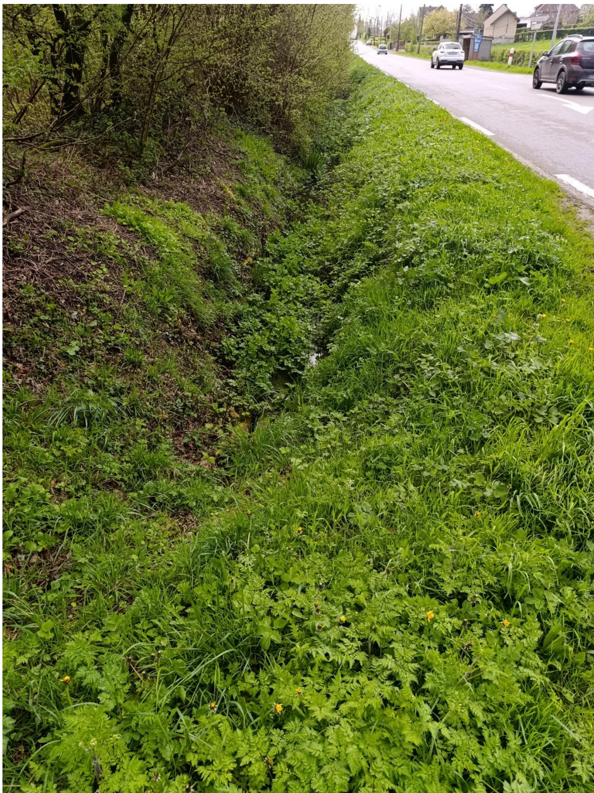
Le fossé en contrebas de « la chaussée Brunehaut » (RD932) à Villereau : zone d'habitat d'espèces protégées identifiées. (le 09/04/2024)
